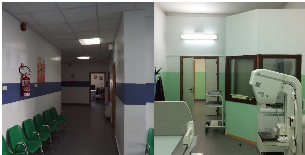
Figura 11 – Controsoffitto presente nei corridoi e rivestimento delle pareti della Sala RX al piano seminterrato
