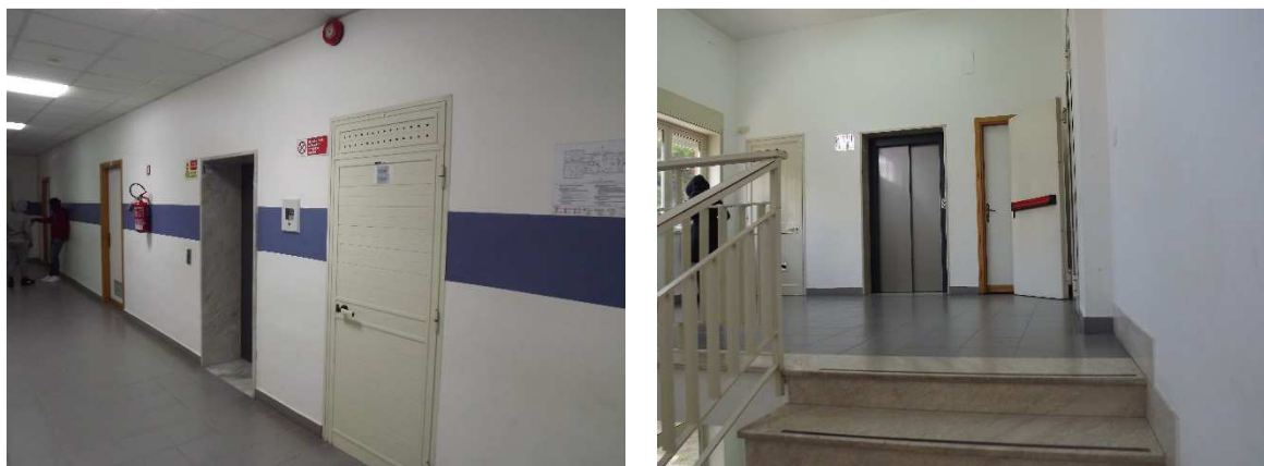
Figura 7 – Ascensore zona Sud (corridoio) e zona Nord (interno al vano scala)
