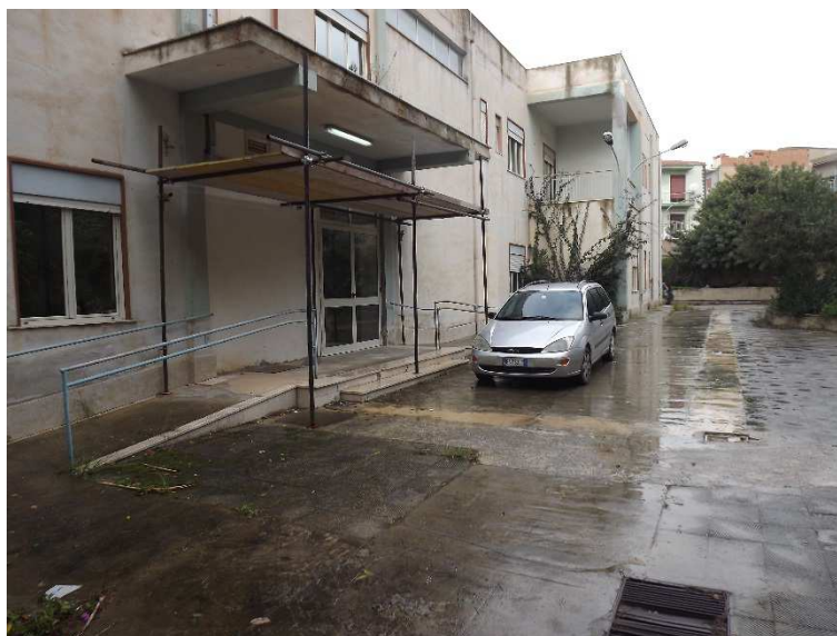
Figura 5 – Ingresso posteriore al piano terra – Prospetto Est
