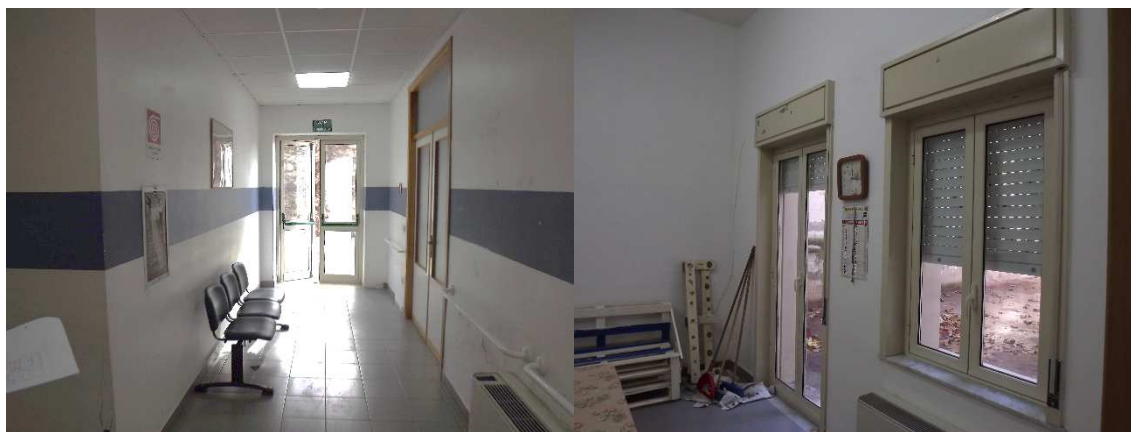
Figura 10 – Uscita di emergenza al piano seminterrato e infissi esterni
