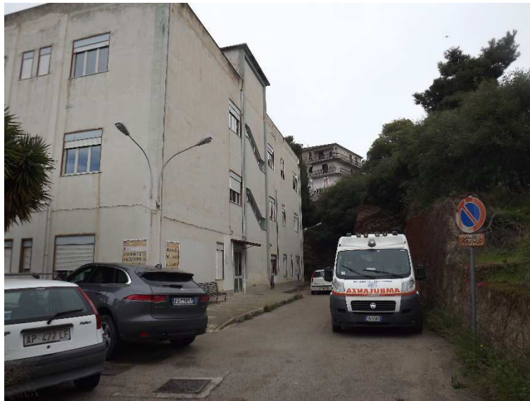
Figura 3 – Ingresso al piano seminterrato – Prospetto Sud
