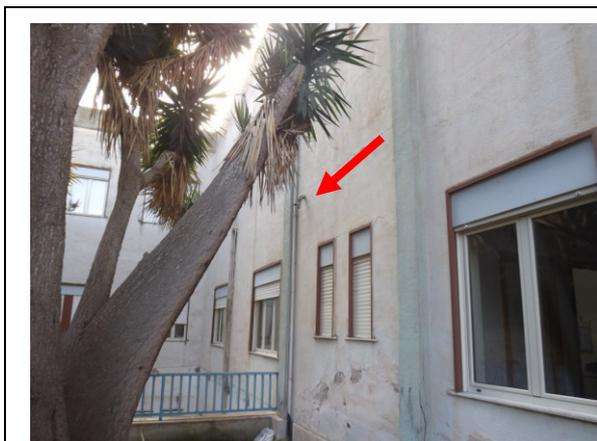
**Foto 3** – La freccia in rosso indica il punto di sbocco della condotta di distribuzione idranti UNI 45 a servizio del piano terra
