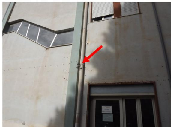
**Foto 4** - La freccia in rosso indica il punto di sbocco della condotta di distribuzione idranti UNI 45 a servizio del piano seminterrato
